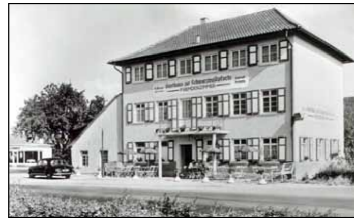
Nach der Aufstockung
