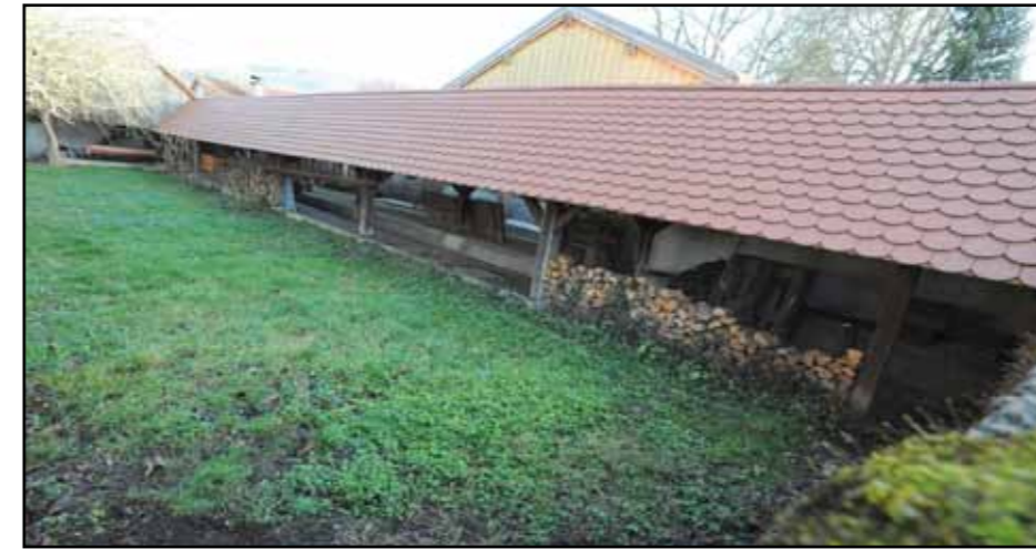
Früher war hier die überdachte Kegelbahn, 2016 fotografiert
