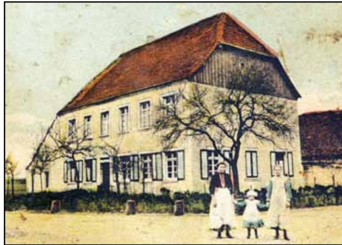
Vor der Aufstockung
