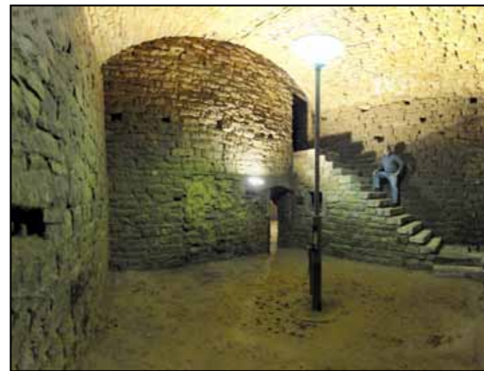
Einer der drei unterirdischen Räume des Bierkellers
